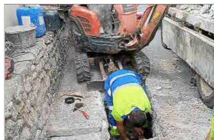
Operaris d'Aqualia treballen en l'avaría de la canonada.
